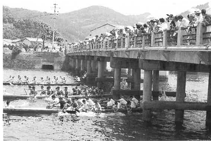
旧水俣大橋でのスタート！
